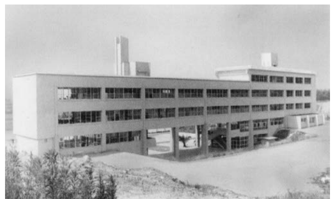
A棟 - 1969(昭和44)年
